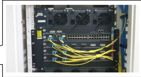
写真 1 4 スイッチ (Cisco 社製 Catalyst 4000)
