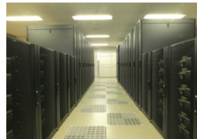
スカラ型並列コンピュータ(LX 406Re-2)、ストレージシステム
